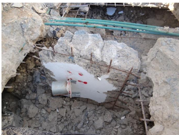
Figura 09 – Base do limitador de vaga fixado na laje
