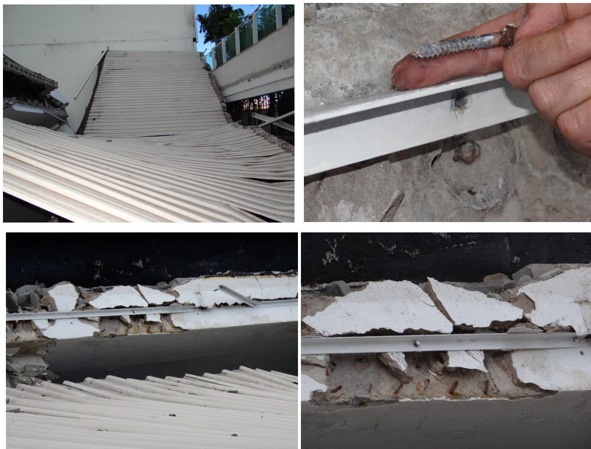
Figura 18 – Execução de fixação de cobertura do bicicletário na laje
