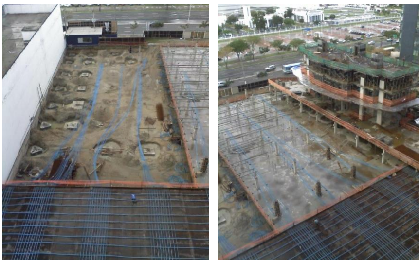
Figura 11 – Execução da laje do PUC quando da época da construção
