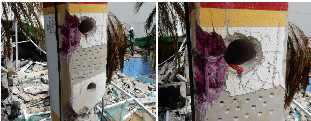
Figura 05 – Corpos de prova retirado na estrutura e ensaios realizados
