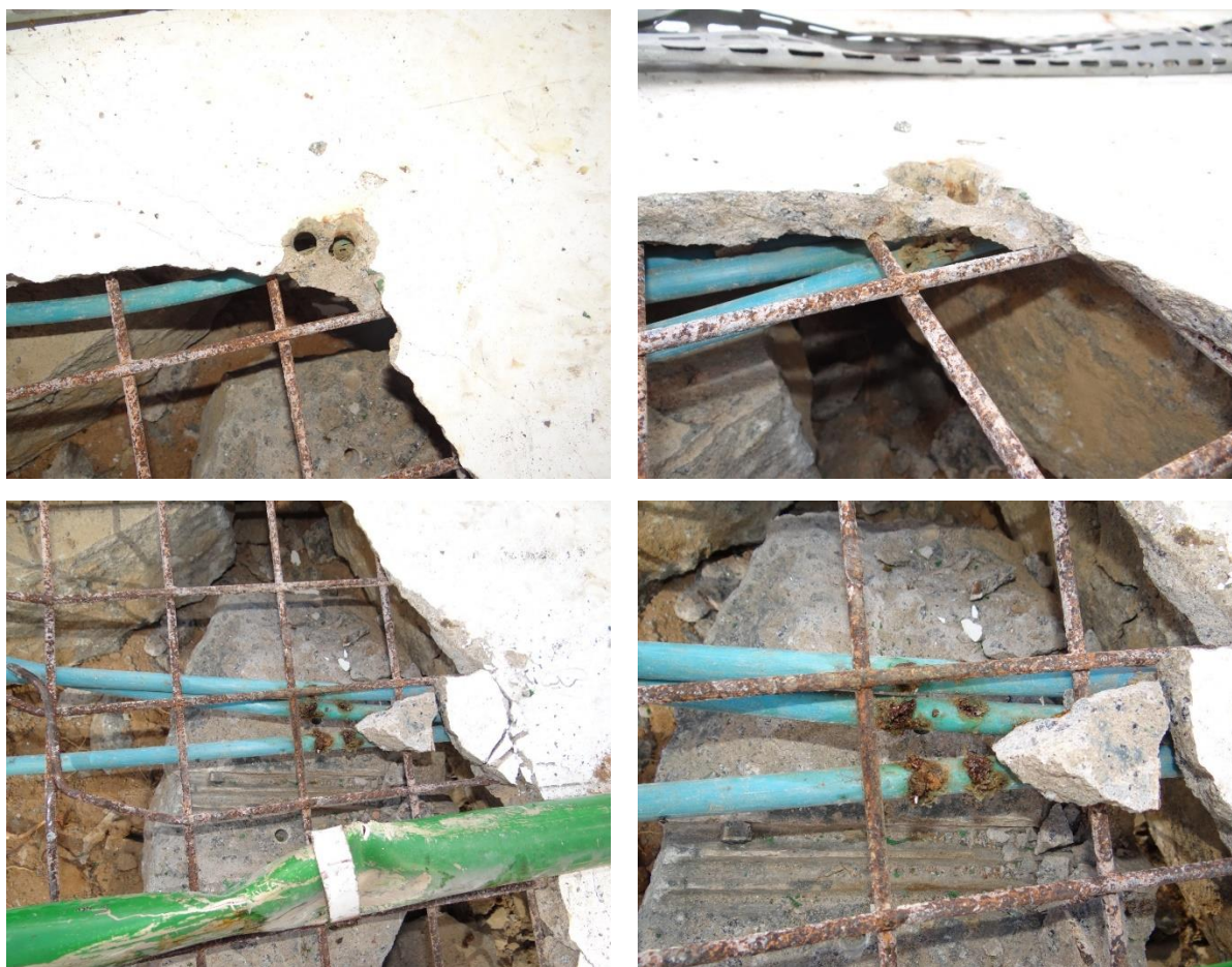
Figura 20 – Bainha das cordoalhas atingida
