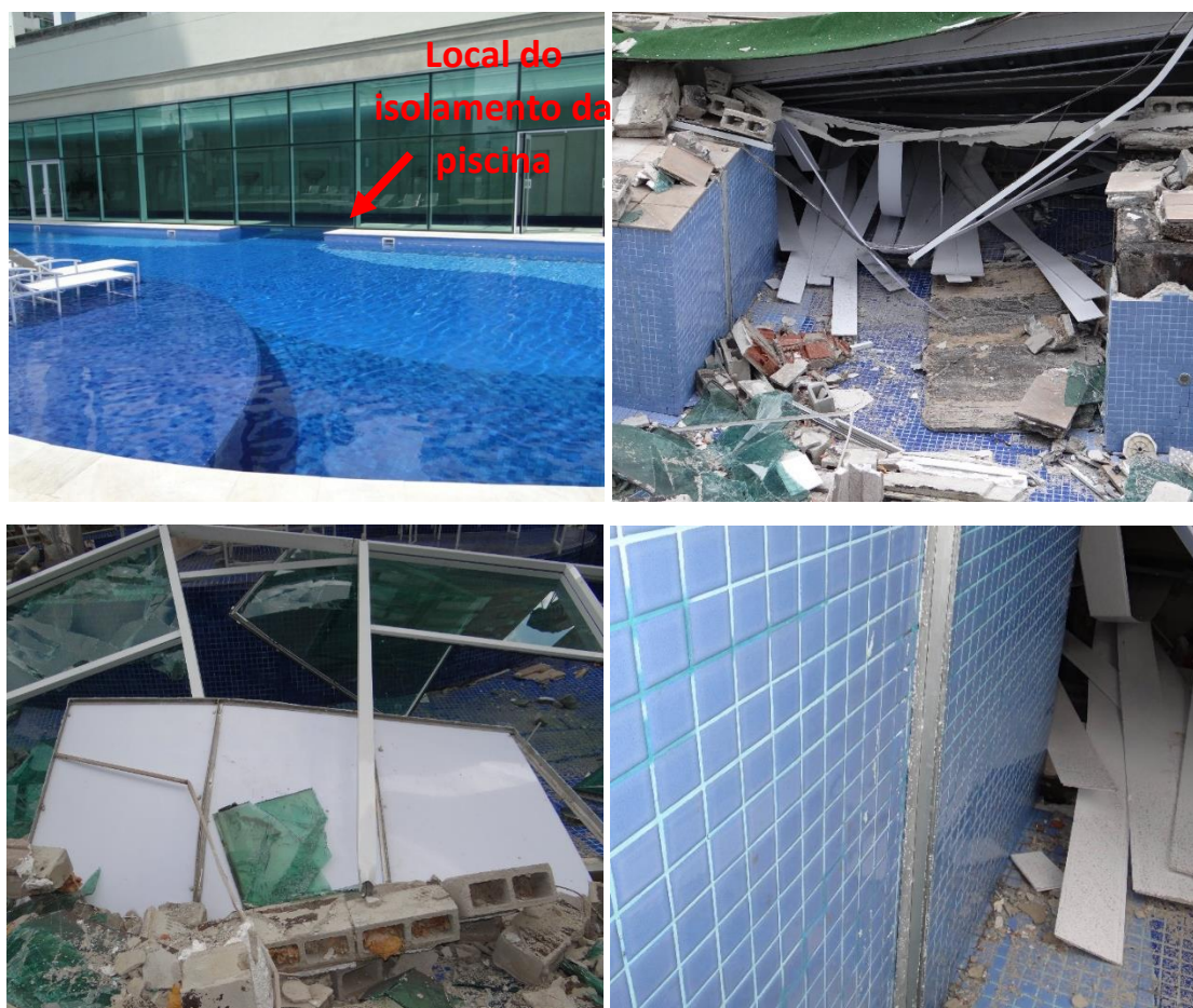
Figura 08 – Isolamento entre piscinas executado pelo condomínio
