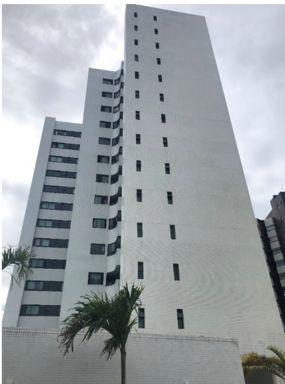
Figura 02 – Fachada frontal do edifício (Sul)
