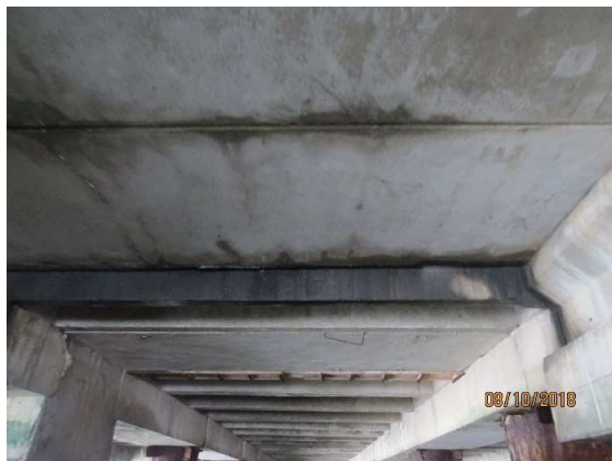
Figura 43 – PORÇÃO INFERIOR. Notar encontro dos SISTEMAS A e B
