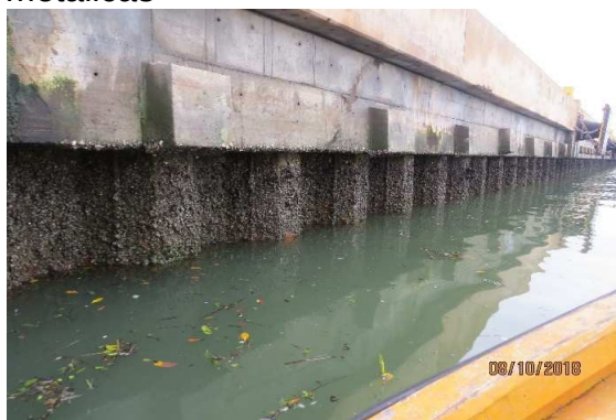
Figura 35 – PORÇÃO INFERIOR. Vista da lateral da ponte de acesso. Notar presença de estacas- prancha metálicas
