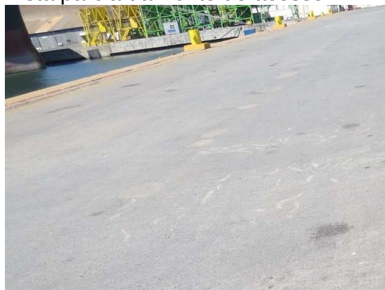
Figura 11 – PORÇÃO SUPERIOR. Vista parcial da Ponte de acesso
