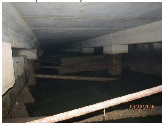
Figura 44 – PORÇÃO INFERIOR. Notar sistema construtivo da ponte de acesso (Sistema B)
