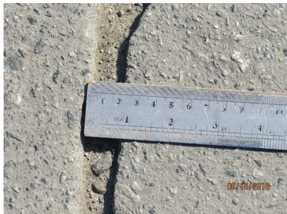
Figura 20 – PORÇÃO SUPERIOR. Detalhe da figura anterior. Observar abertura de 2cm
