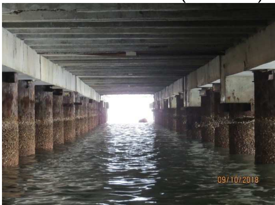
Figura 42 – PORÇÃO INFERIOR. Notar sistema construtivo (Sistema A)
