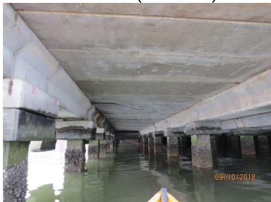
Figura 41 – PORÇÃO INFERIOR. Notar sistema construtivo (Sistema B)
