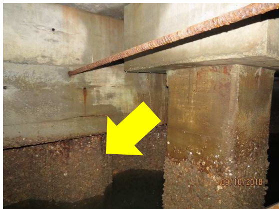
Figura 45 – PORÇÃO INFERIOR. Notar estaca prancha metálica (seta amarela) da ponte de acesso, vista pelo lado interno
