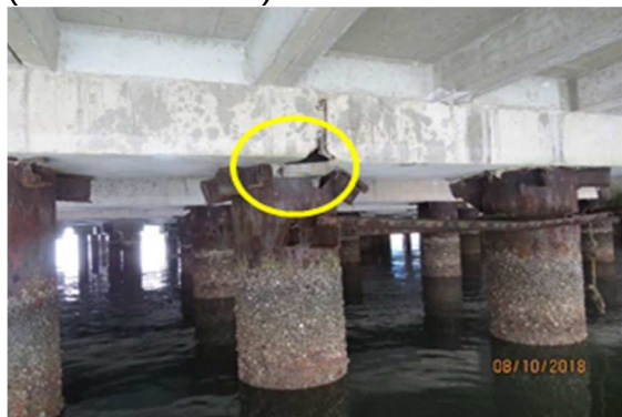
Figura 49 – PORÇÃO INFERIOR. Notar estaca do Sistema A, fora de uso (círculo amarelo)
