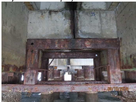
Figura 47 – PORÇÃO INFERIOR. Notar peça metálica remanescente, utilizada para implantação do Sistema A (região da junta de dilatação)
