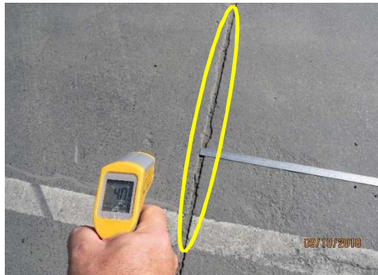
Figura 19 – PORÇÃO SUPERIOR. Junta de dilatação (círculo amarelo). Notar temperatura do substrato igual a 40°C
