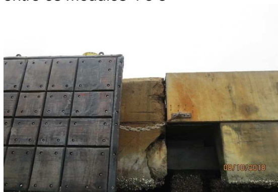
Figura 36 – PORÇÃO INFERIOR. Notar encontro do Sistema A (lado esquerdo) com o Sistema B (lado direito) formando a junta de dilatação entre os módulos 4 e 5
