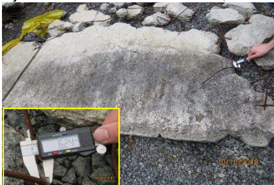
Figura 24 – Bitola da armadura da capa da laje dos reservatórios medindo 6,24 mm
