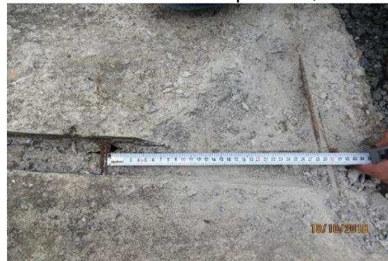
Figura 25 – Espaçamento longitudinal da armadura da capa da laje dos reservatórios medindo aprox. 15,0 cm
