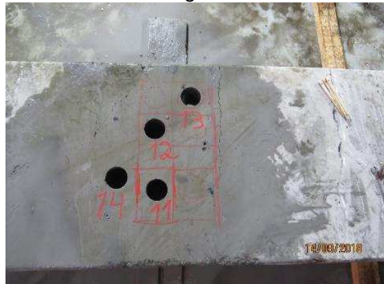
Figura 17 – Extração de testemunhos. Furos da extração dos últimos quatro testemunhos da viga VP-02 Eixo 02
