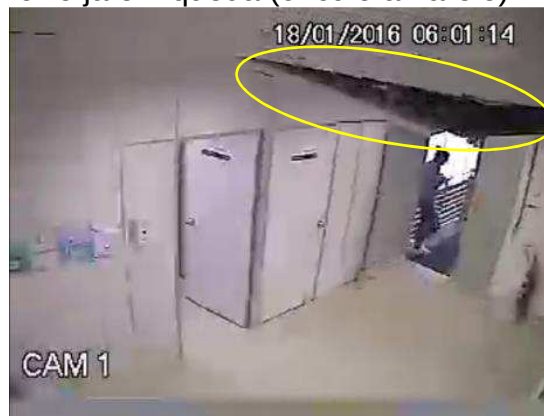
Figura 58 – Colapso em curso. Notar forro já em queda (círculo amarelo)
