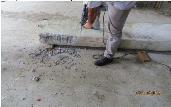
Figura 20 – Rompimento da VP02 Eixo 02 para verificação das armaduras
