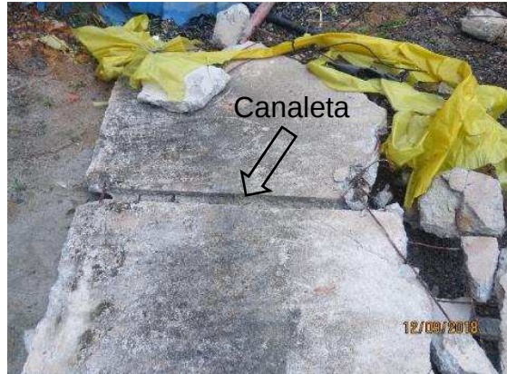
Figura 19 – Capa da laje dos reservatórios com canaleta para escoamento de água
