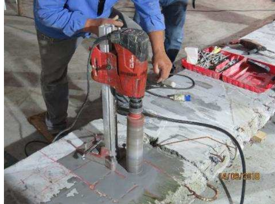
Figura 15 – Extração de testemunhos. Equipamento posicionado para extração na viga VP-02 Eixo 02
