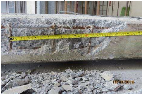
Figura 22 – Estribos posicionados após a armadura de suspensão espaçados a cada 16,50 cm, aproximadamente
