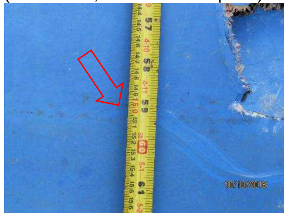
Figura 35 – Destroços dos reservatórios. Marca d' água do nível típico inferior (distante 150,0 cm da borda superior)
