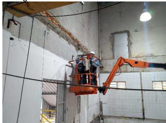
Figura 13 – Extração de testemunhos. Equipamento posicionado para extração na viga VP-02 Eixo 01
