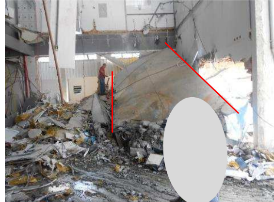
Figura 52 – Laje dos reservatórios, em sua porção mais preservada (entre linhas vermelhas).
