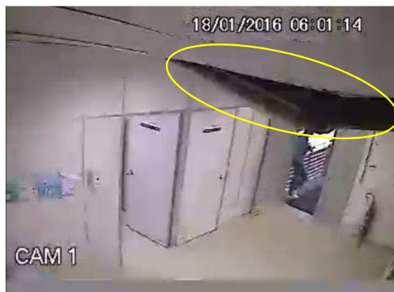
Figura 59 – Colapso em curso. Notar forro em queda (círculo amarelo)
