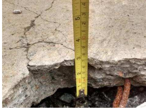
Figura 27 – Capa da laje medindo aproximadamente 7,0 cm de espessura
