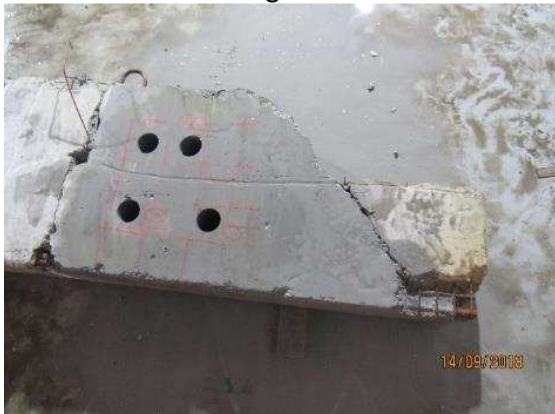
Figura 16 – Extração de testemunhos. Furos da extração dos primeiros quatro testemunhos da viga VP-02 Eixo 02
