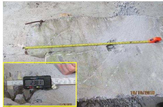
Figura 23 – Armadura do tirante da viga VP-02 do eixo 02 medindo aproximadamente 72 cm com bitola de 24 mm
