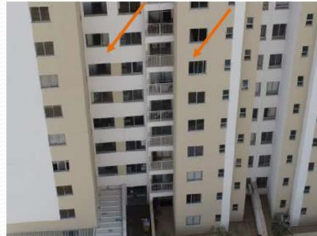
Imagem 33 - Anel de cintamento com barras chatas para equipotencialização c
