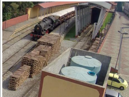
Um dos dois reservatórios de água da estação de Guararema está destampado (Foto: José Antônio de Assis/ arquivo pessoal)
