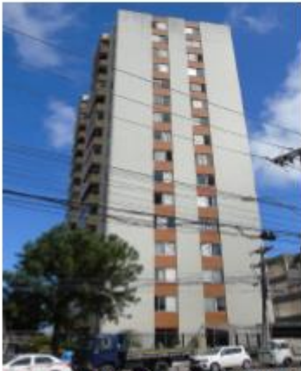
Foto 1 – Fachada Norte do Condomínio Cidade de Sevilla
