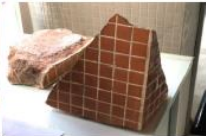
Foto 49 – Fragmentos deslocados da fachada.
