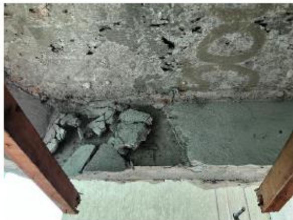
Foto 18 – Detalhe da tela no revestimento.
