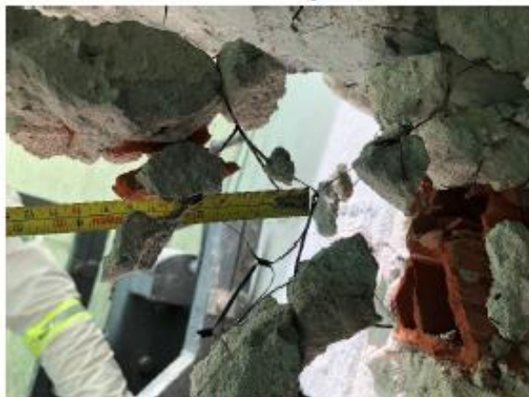
Foto 17 – Vista da abertura da malha da tela (50mm).
