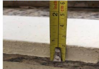
FOTO 7 – Espessura de uma peça de mármore.
