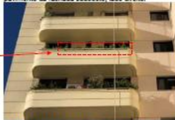
FOTO 51 - Marmore removido no 6º pavimento da fachada sudoeste, lado esquerdo.
