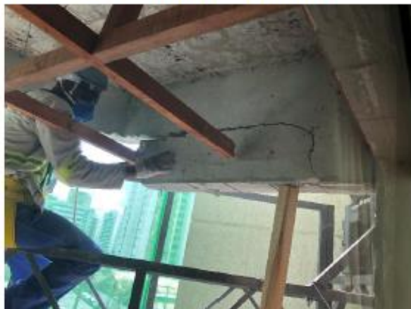
Foto 15 – Vista da remoção da alvenaria.
