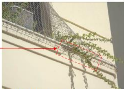
FOTO 17 – Detalhe da FOTO 16.
