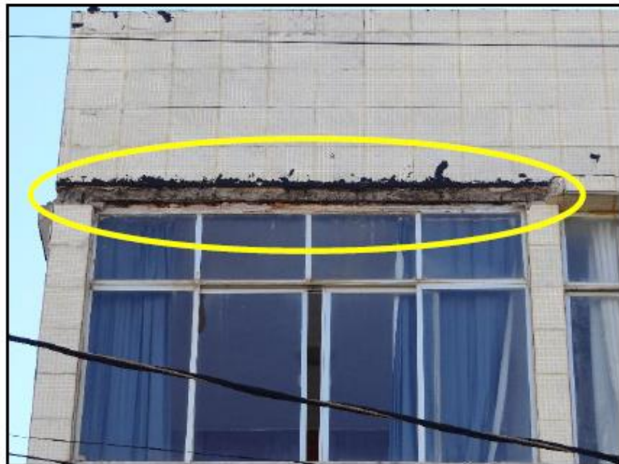
Foto 4 – Região entre o segundo pavimento e a cobertura.
