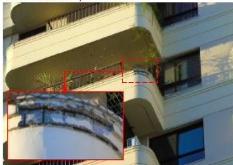
FOTO 15 – Concreto removido no 11º pavimento da fachada sudoeste, lado esquerdo.
