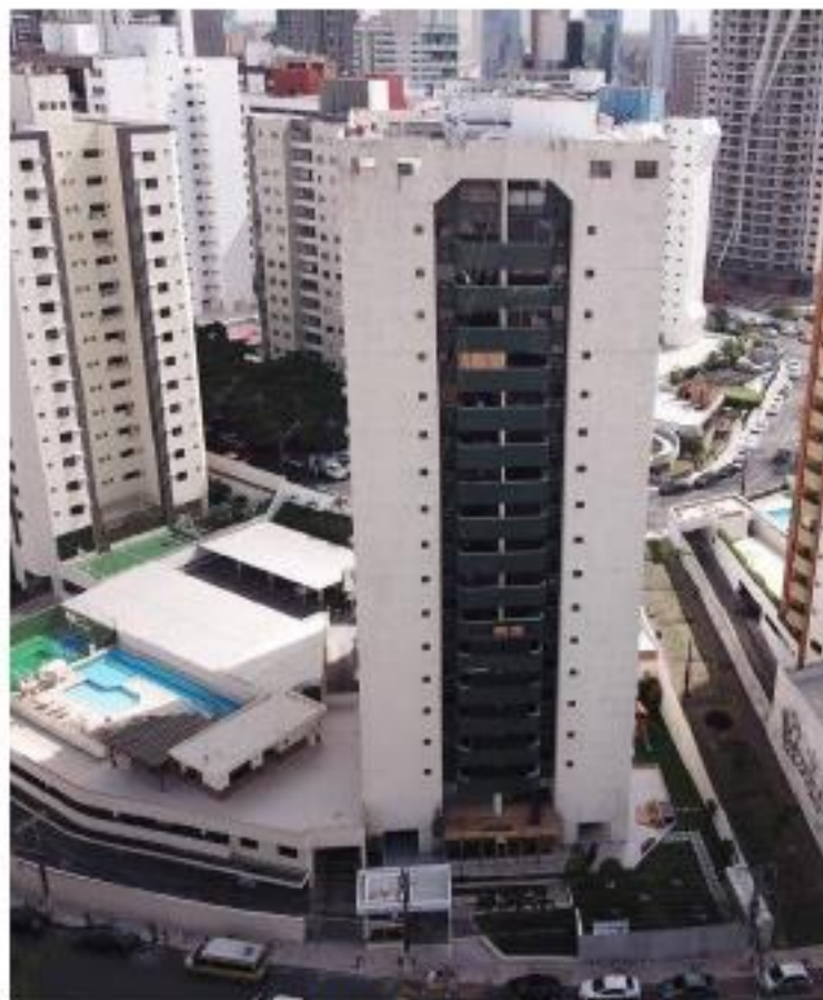
Foto 1 – Vista Frontal do prédio.
