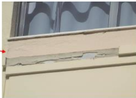
FOTO 19 – Detalhe da FOTO 18 com a resina utilizada na colagem das peças.
