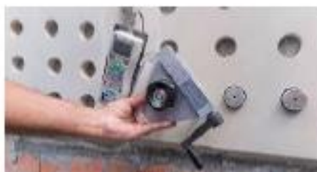
Foto 50 – Ensaio de resistência de aderência à tração.
