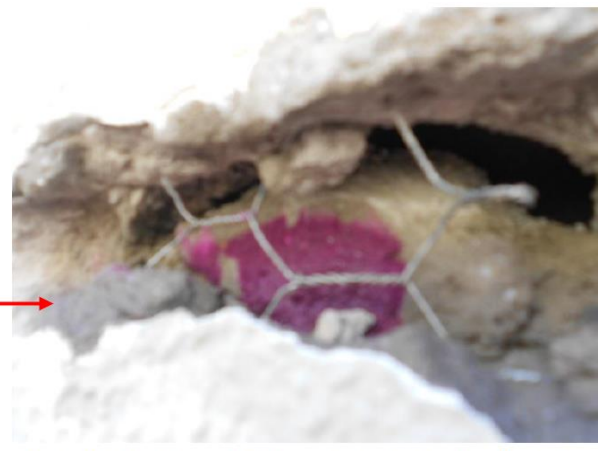
Foto 06: Detalhe da tela e do teste de alcalinidade.
