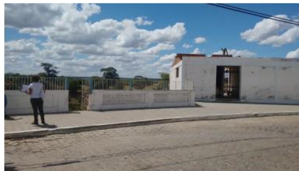
Figura 2 – Vista da fachada frontal e entrada secundária.
