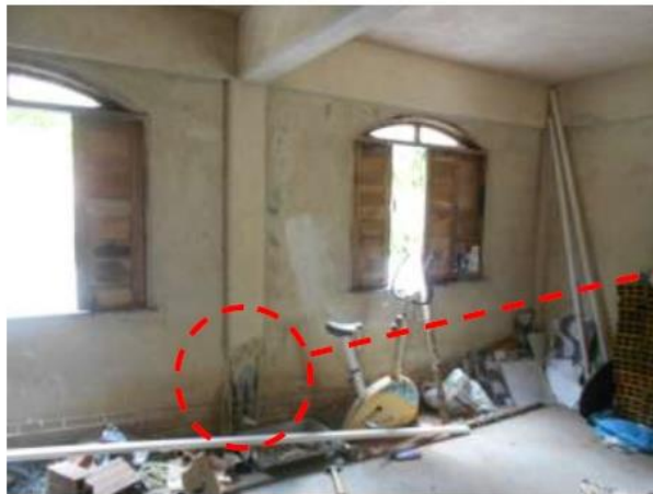
Foto 11: Vista do pilar do pavimento 1.
