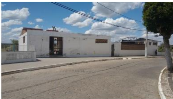
Figura 1 – Vista da fachada frontal e entrada principal.
