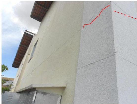
Foto 11: Vista 2 da fachada lateral esquerda.
