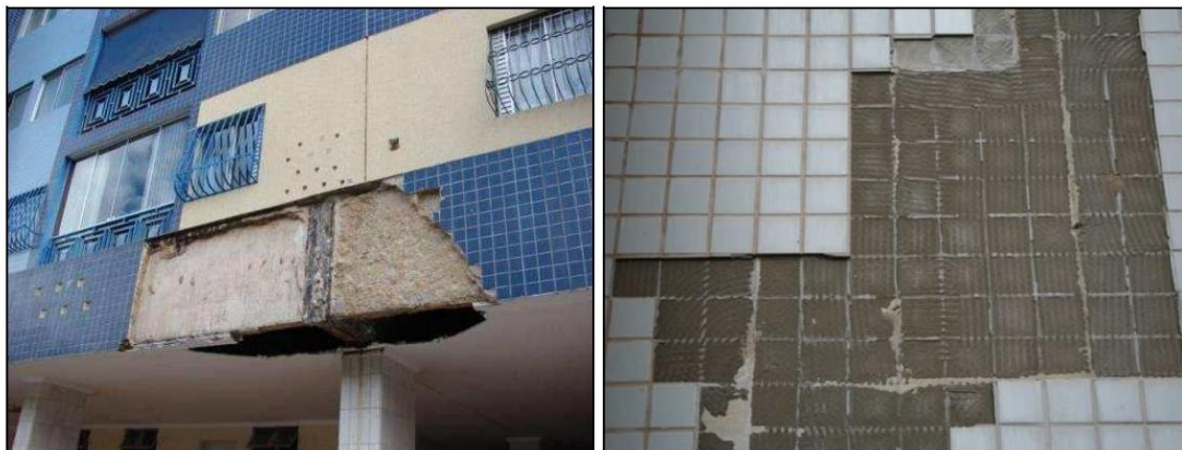
Figura 2.22 - Deslocamento localizado do emboço (esquerda) e de peças cerâmicas (direita) (LEM- UnB, arquivo fotográfico).
