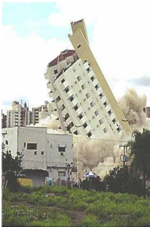
Edifício Itália – Desabamento – 1997 – S. J. do Rio Preto - SP
