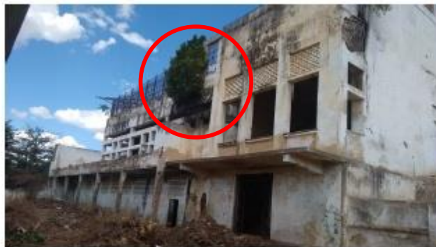
Figura 15 – Vista da fachada de fundo.
