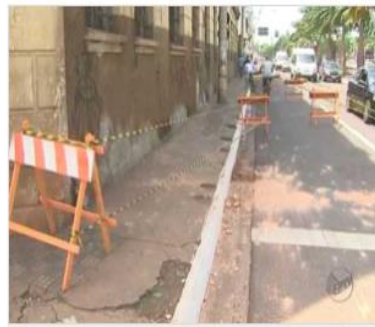
Faixa de avenida e a calçada do imóvel foram interditadas na manhã desta terça-feira (22).
