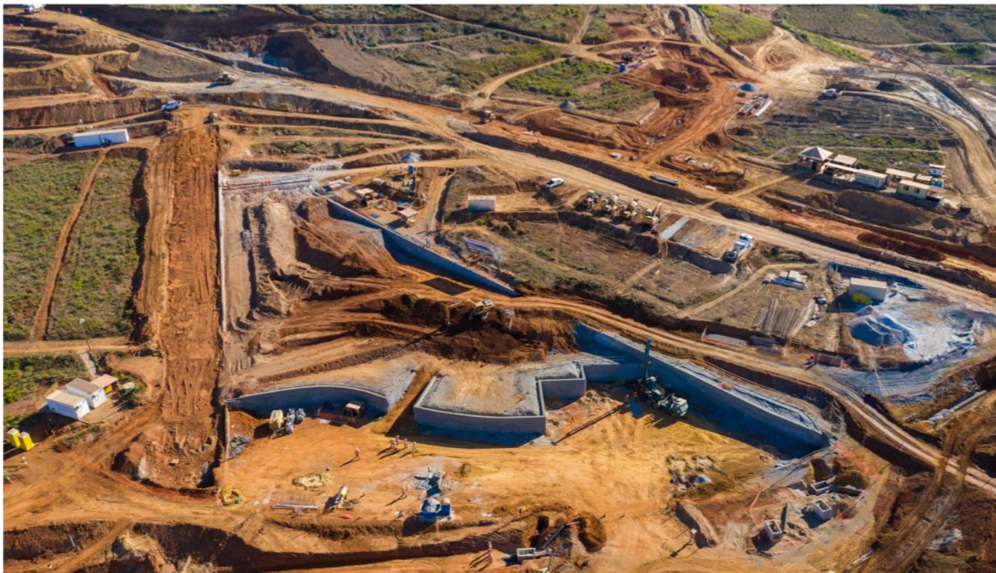
Obras do reassentamento de Bento Rodrigues (Julho/2019)
