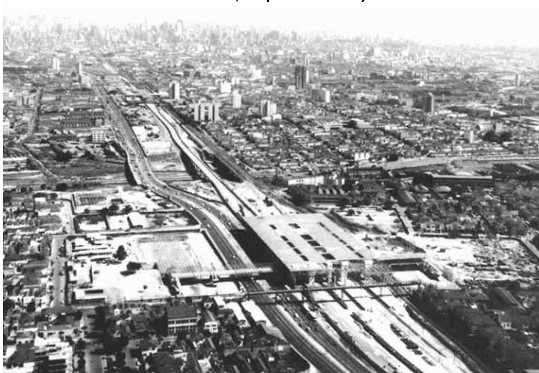
Figura 14: Radial Leste (em direção ao Centro), destacando a estação Tatuapé do Metrô e o Shopping Metrô Tatuapé em construção em 1981 (à direita e esquerda da avenida, respectivamente)
