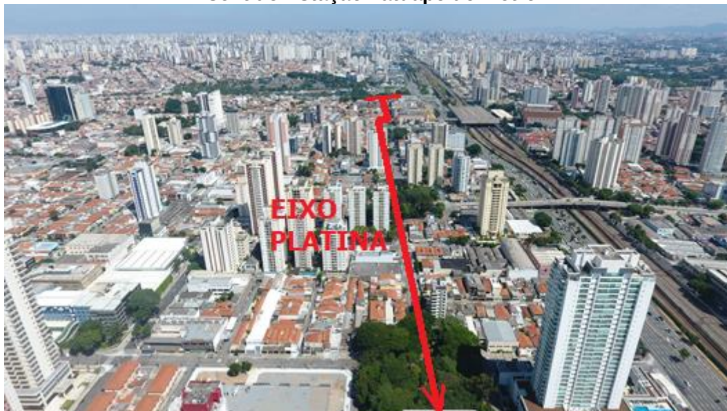
Figura 8: Fotografia da área envoltória ao “Eixo Platina” sentido Estação Tatuapé do Metrô
