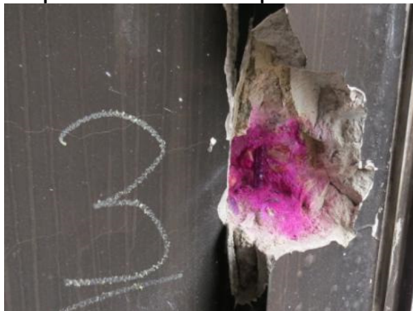
Figura 11 – SALA 09. INSPEÇÃO ESTRUTURAL. No detalhe, ponto 08 localizado em laje, apresentando pH insatisfatório (ausência de coloração rosa), baixo cobrimento e armadura íntegra (CA 60, aço laminado a quente). A situação encontrada neste ponto da laje se repete na maioria dos pontos
