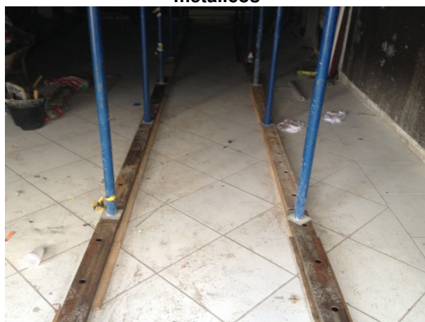
Figura 20 – SALA 09. Notar posicionamento das armaduras (marcações feitas com giz branco)
