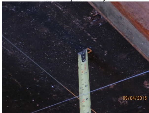
Figura 42 – SALA 09. Análise de potencial de corrosão em laje, por uso de milivoltímetro
