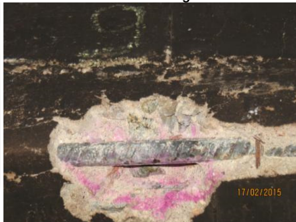
Figura 12 – SALA 09. LAJE DE TETO. Notar região próxima ao ponto 15, apresentando deterioração do cobrimento (“ spalling ”) com exposição das ferragens
