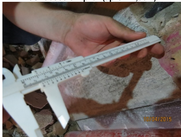
Figura 32 – SALA 09. Aferição da espessura do reboco em pilar (aprox. 1,5cm).
