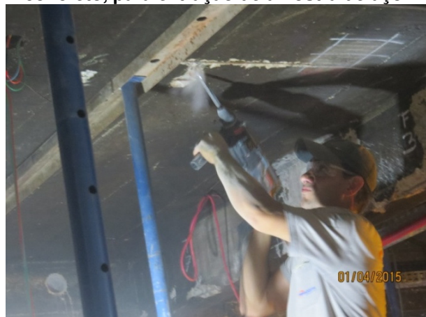
Figura 35 – AMOSTRAS DE AÇO RETIRADAS. Notar identificação adotada (estribos – vigas e lajes)
