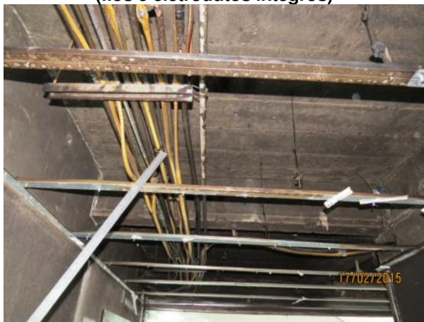
Figura 6 – SALA VIZINHA À SALA 09. Notar integridade das estruturas sobre o forro, evidenciando que a região não foi diretamente atingida pelas chamas
