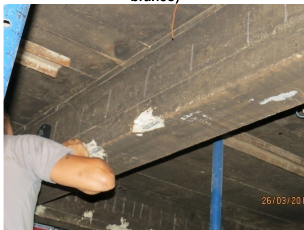
Figura 20 – SALA 09. Notar posicionamento das armaduras (marcações feitas com giz branco)
