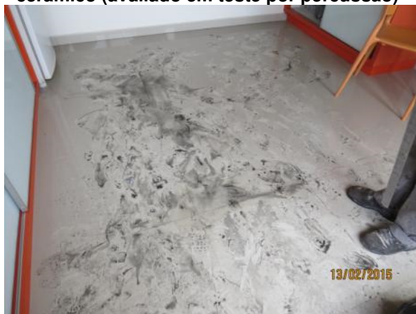
Figura 7 – REGIÃO SOBRE A SALA 09. Observar integridade do revestimento cerâmico (avaliado em teste por percussão)
