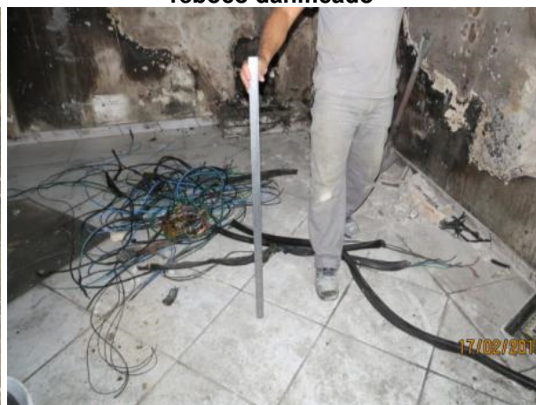
Figura 14 – SALA 09. TESTE DE PERCUSSÃO. Detecção de diversas placas cerâmicas em processo de deslocamento. Notar também reboco danificado
