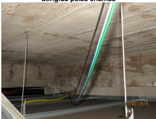
Figura 8 – REGIÃO ABAIXO DA SALA 09. Notar integridade das estruturas, inclusive com preservação do sistema de pintura
