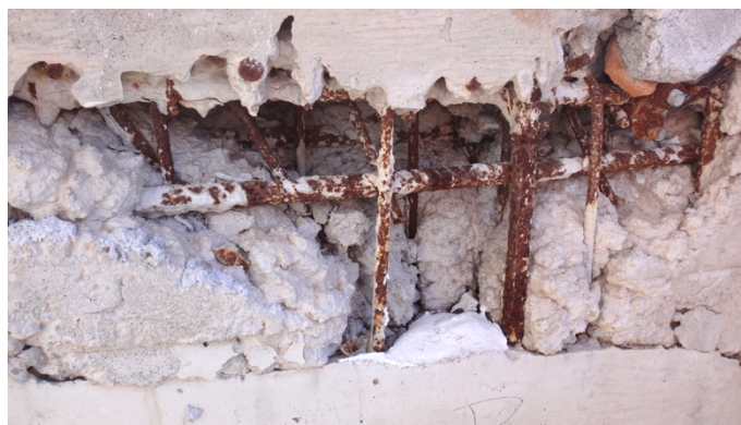
Fotos 1 e 2: Armadura exposta em edificação nova (6 meses). Fonte: Arquivos do autor.
