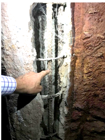
Fotos 1 e 2: Armadura exposta em edificação nova (6 meses). Fonte: Arquivos do autor.
