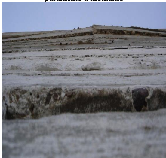
Figura 06 – Detalhe no sentido vertical do paramento a montante
