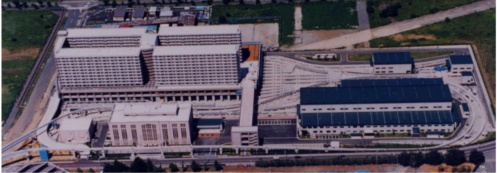
Empreendimento sobre o pátio Tama Monorail (região noroeste de Tokyo)
