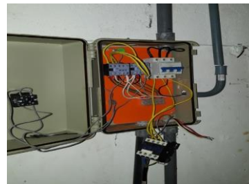
Instalações fora dos padrões técnicos NBR 5410 e normas de segurança NR10
