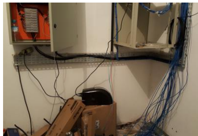
Instalações fora dos padrões técnicos NBR 5410 e normas de segurança NR10
