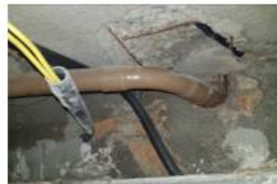
Ferragem exposta na laje e vestígios de reparos na laje e nas tubulações
