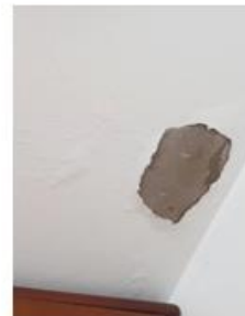
Ferragem exposta na laje e vestígios de reparos na laje e nas tubulações
