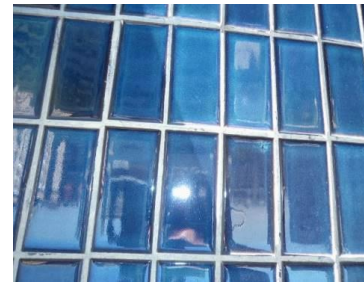
Revestimento de pastilhas cerâmicas da fachada
