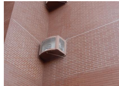
Serviços de manutenção corretiva
