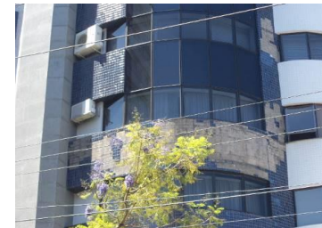
Remoção de pastilhas da fachada
