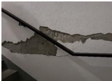
Desagregação da textura e reboco, e lascamento do piso cimentado
