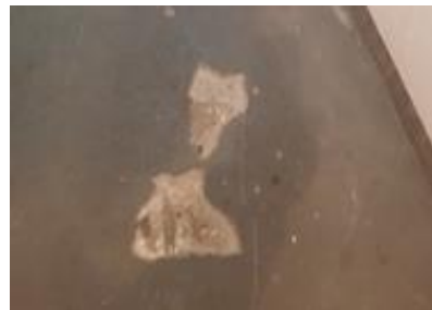
Desagregação da textura e reboco, e lascamento do piso cimentado
