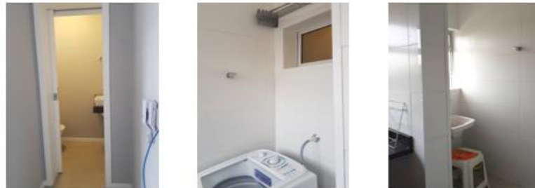
Modificações (demolição/construção de parede) no lavabo e área de serviço
