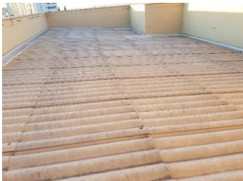
Recobrimento longitudinal c/ frestas nos trespases
