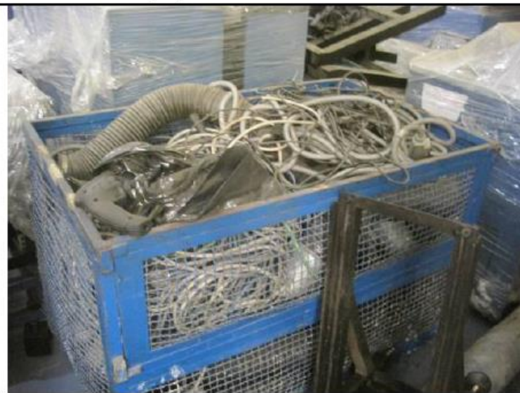
Detalhe da parte elétrica e de automação retirada do equipamento de forma inadequada
