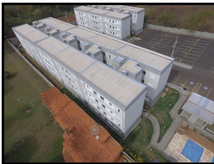
Figura 12 - Imagem Aérea Vistoria Entrega de Obra. Fonte: Autor - Drone Phantom 4.
