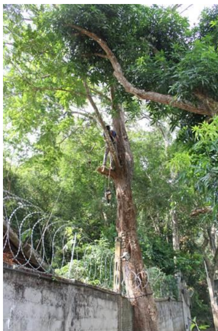
Fig. 17: Galhos sendo podados indevidamente.
