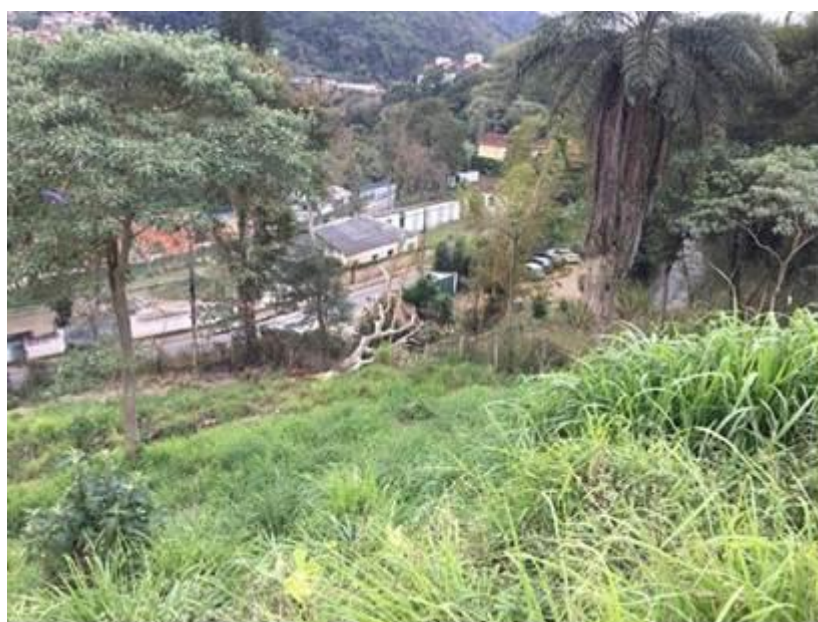
Fig. 40: Foto da área com remoção da Mata Atlântica original e fragilidade do solo
