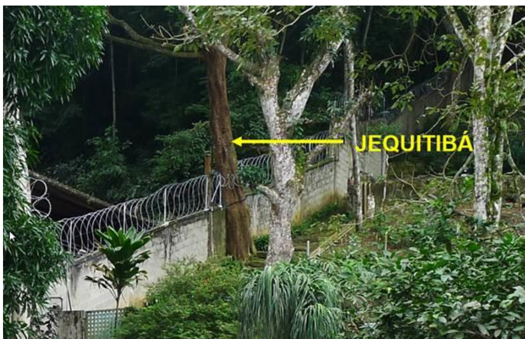
Fig. 09: Muro de divisa na área dos fundos
