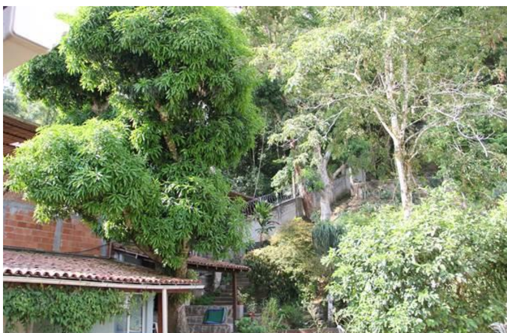
Fig. 08: Muro de divisa na área dos fundos
