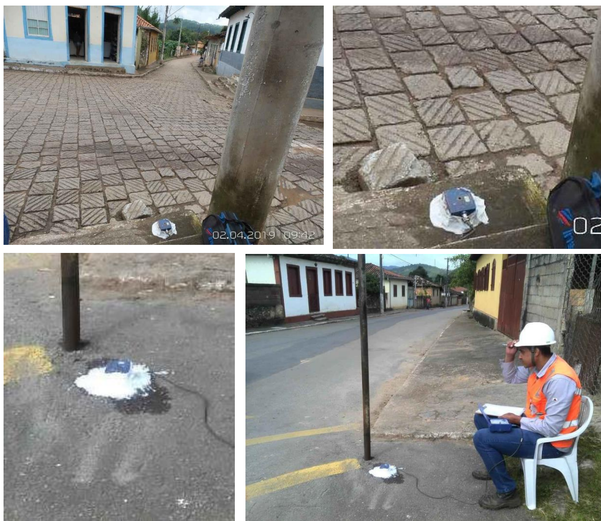
Figura 9 - Imagens mostrando o posicionamento e a fixação dos instrumentos para o monitoramento. Fonte: Elaborada pelos autores.
