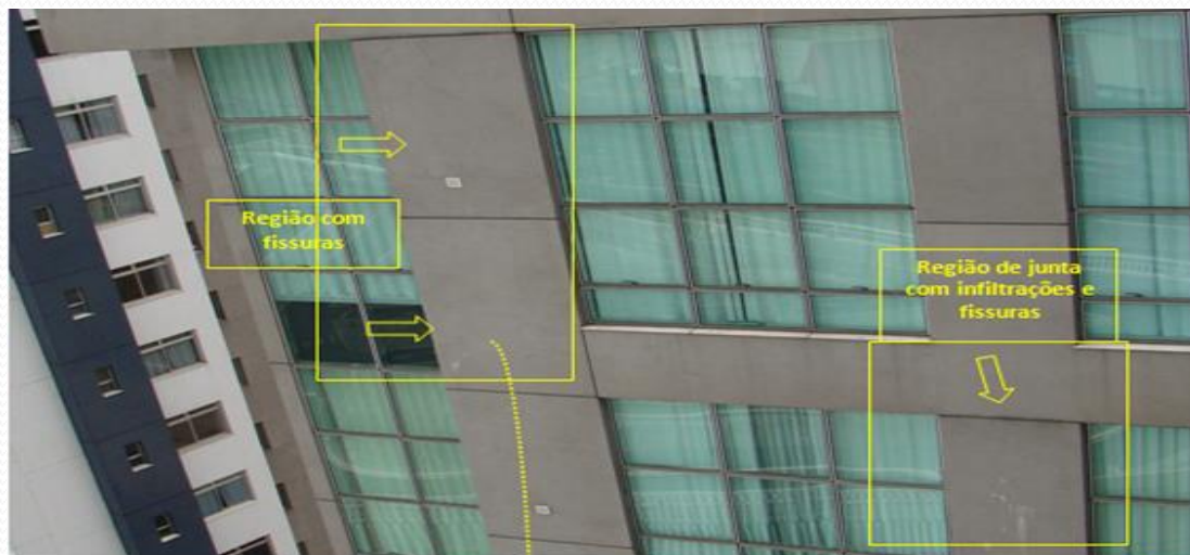
Fotos em 21/10/2011: fachada do BLOCO A com trecho lateral ainda com pouca eflorescência, mas as contínuas infiltrações pelos rejuntos desgastados e não substituídos, causam fissuras devido ao desprendimento do revestimento
