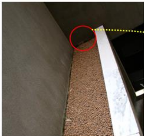
Vista interna da laje e, ao fundo, o ralo
