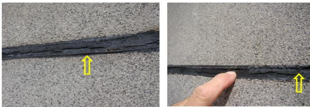
Rejuntamento ressecado – vida útil já encerrada há muito
