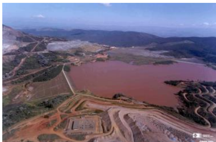
Barragem da Vale, Conceição, Itabira/MG
