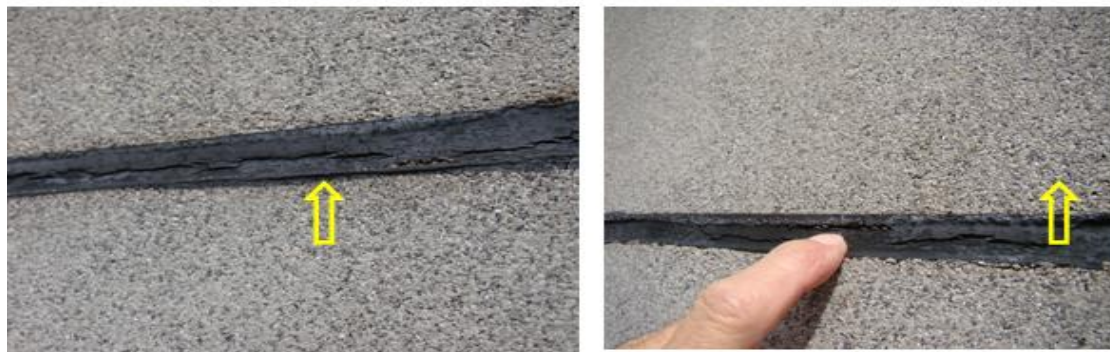
Rejuntamento ressecado – vida útil já encerrada há muito
