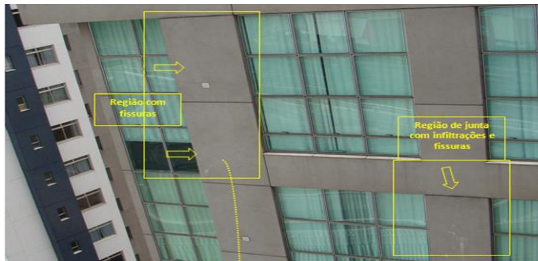
Fotos em 21/10/2011: fachada do BLOCO A com trecho lateral ainda com pouca eflorescência, mas as contínuas infiltrações pelos rejuntas desgastados e não substituídos, causam fissuras devido ao desprendimento do revestimento
