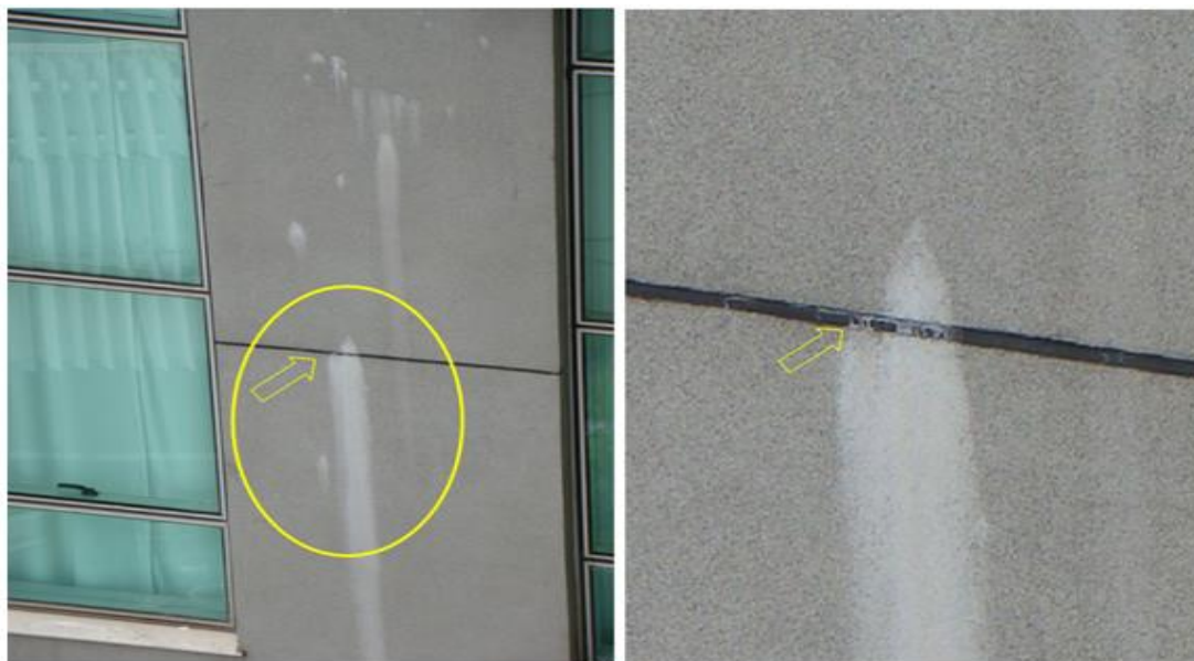
Detalhes do rejunte em fragmentação
