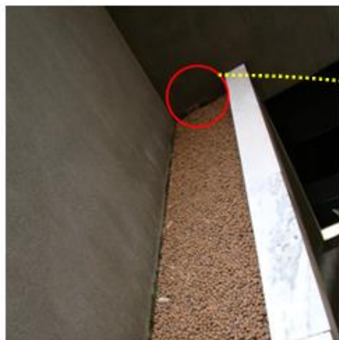
Vista interna da laje e, ao fundo, o ralo
