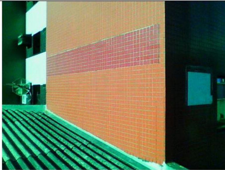
Figura 1 – Área inspecionada para calibração de padrões
