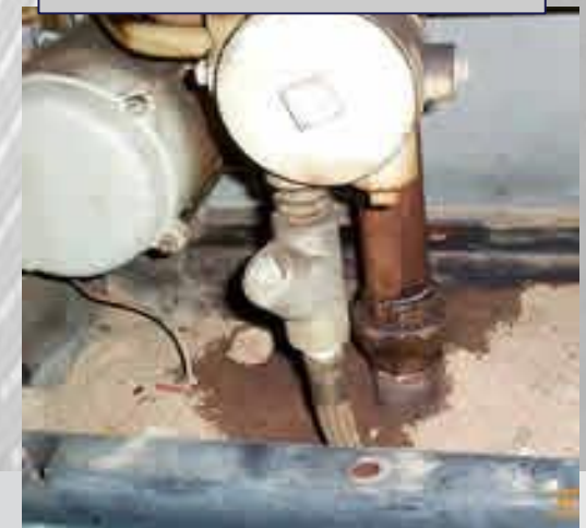
Válvula vazando
