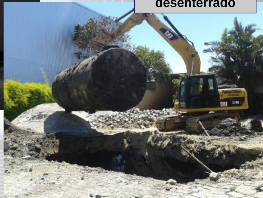
Tanque sendo desenterrado
