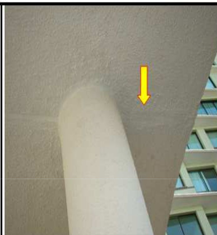
Novo mastique e repintura
