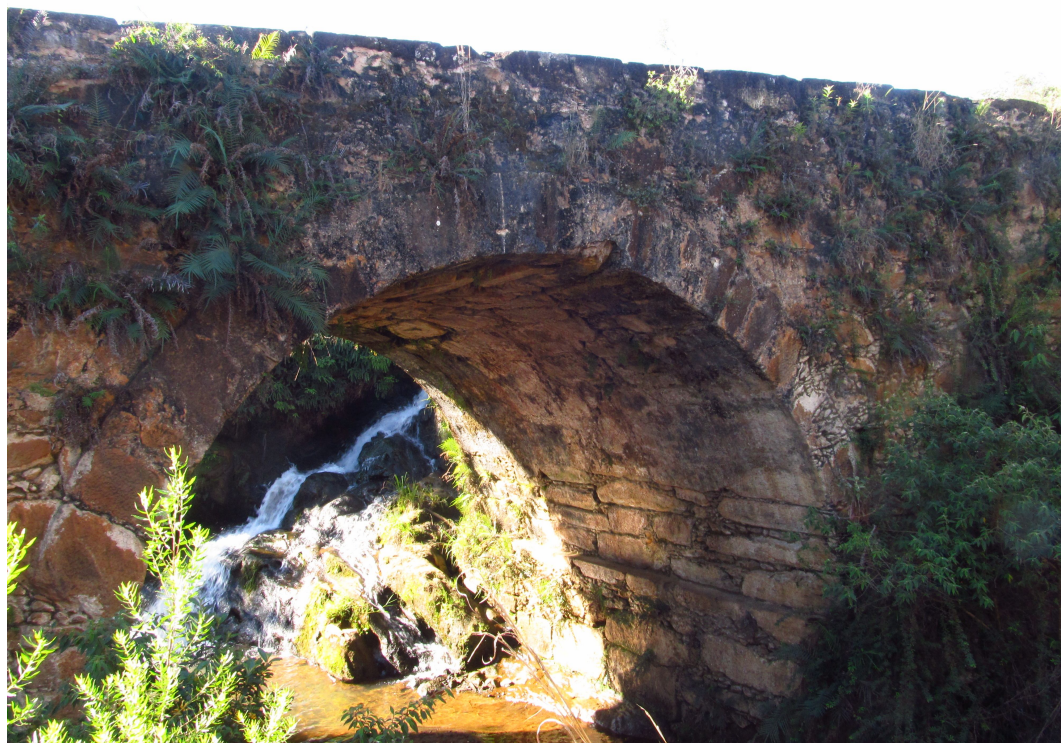
Pontes Estrada Real Trecho Ouro Preto / Ouro Branco
